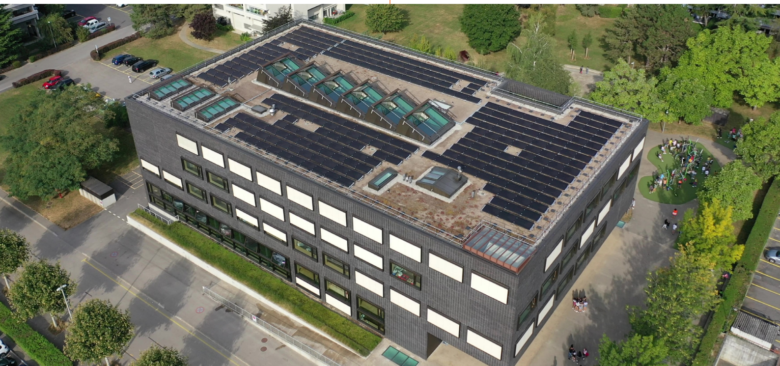
Toit du collège des Tuillières dans le cadre du projet Coopératives solaires
