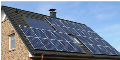
Un toit avec des cellules solaires.
