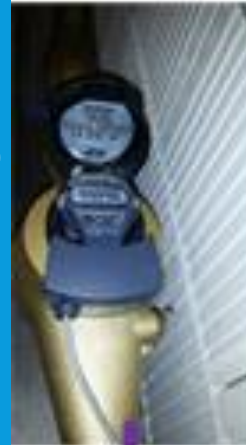
Compteur d'eau Client équipé AMBUS
